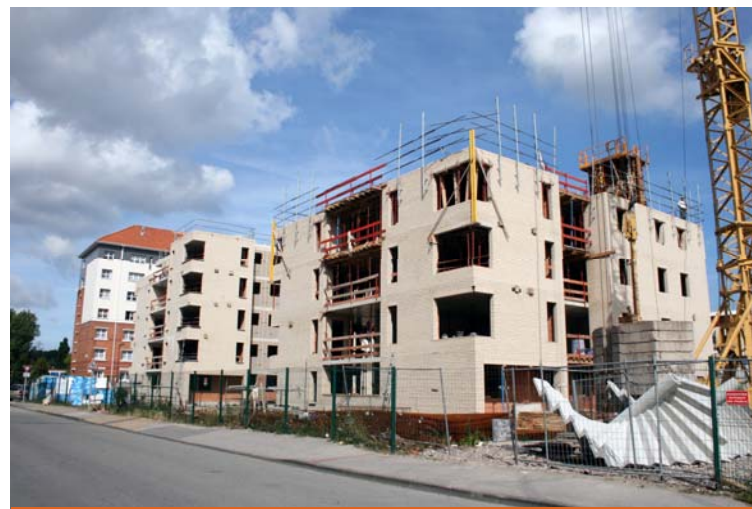
Dunkerque – Jeu de Mail Construction de logements et activités
