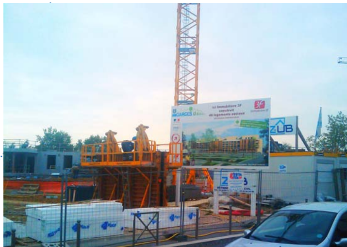
Garges-les-Gonesses - Les Doucettes construction de logements
