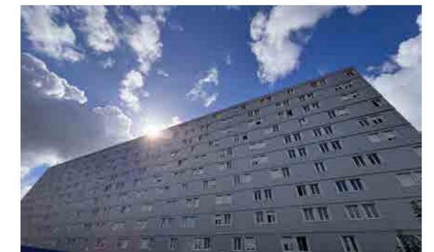
Les travaux ont notamment consisté à remplacer intégralement la façade amiantée, le tout en milieu occupé, par des panneaux en bois et laine de roche préfabriqués en usine. Les bâtiments ont vu leur étiquette énergétique passer de D à B, et leur étiquette d'émission de gaz à effet de serre de E à A. Ces avancées permettent aux résidences d'obtenir la certification NF Habitat et BBC Rénovation.
