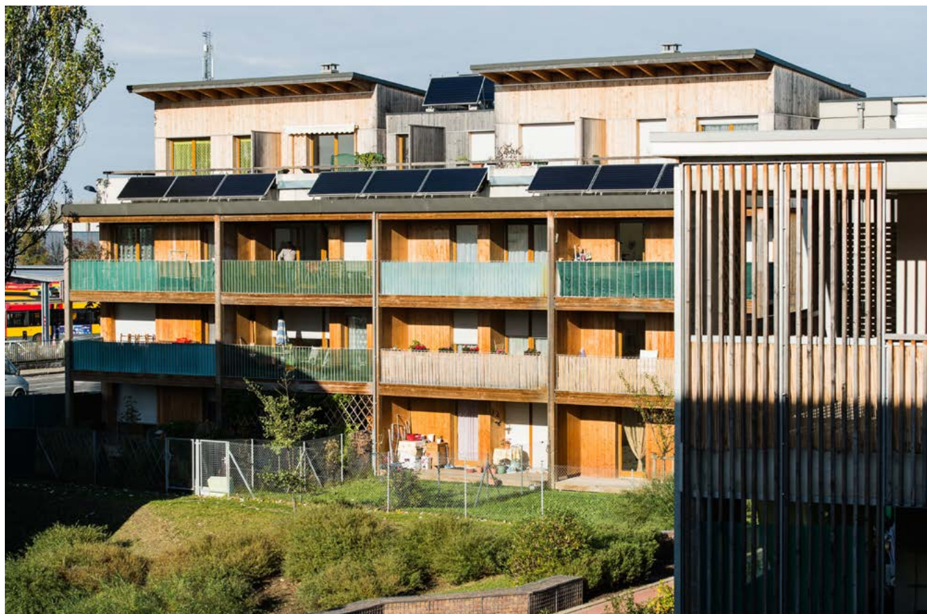
À Mulhouse, le quartier Wolf Wagner a été labellisé Éco-Quartier.
