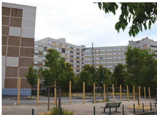
Déconstruction de la tour Iena-Svalis, Châteauroux
