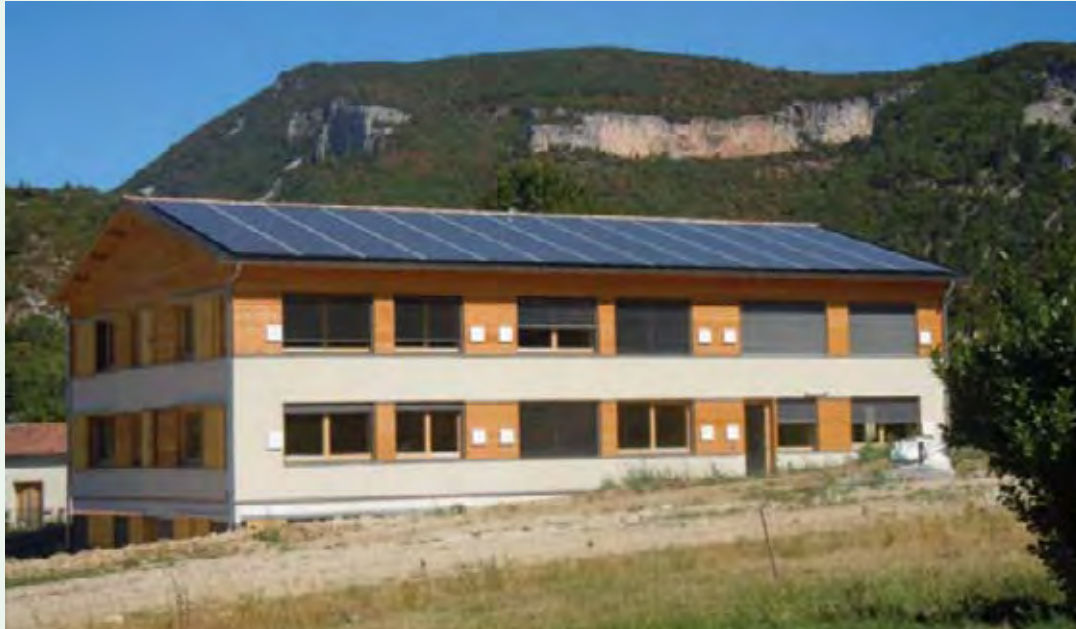
Bâtiment LowCal d'Enertech – Crédit : Enertech
