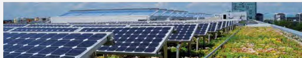
Toit PV vert (Système Heliover) – source : https://www.ecovegetal.com/toitures-vegetales/heliover-photovoltaique
