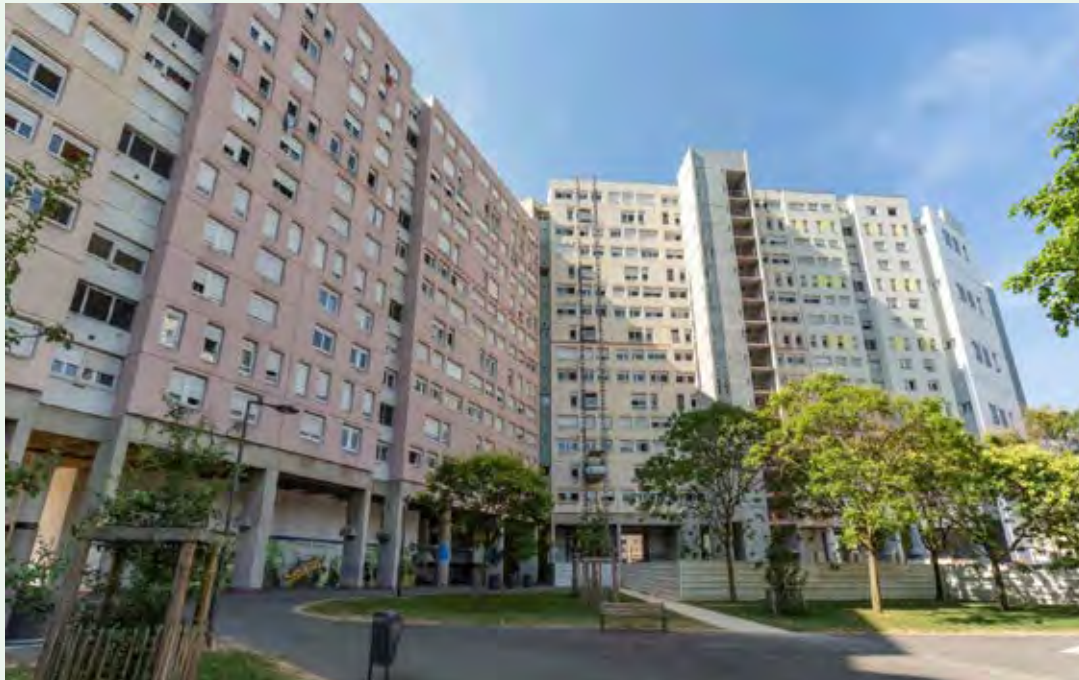
Logements sociaux aux Villeneuves – Crédit : Grenoble-Alpes Métropole
