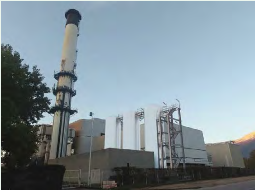
Citernes de stockage d'eau chaude
