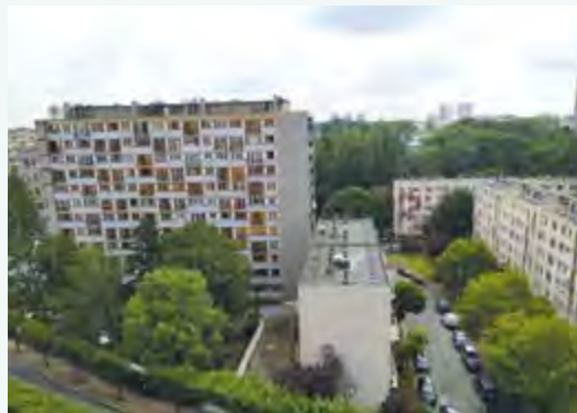
Vue aérienne des bâtiments 8 (démoli) et 6-7 et 7 b (conservés) (juin 2019)
