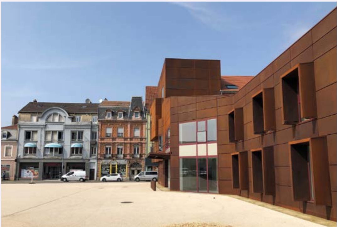
Box Briand – espace dédié à la formation des habitants en cœur de quartier
