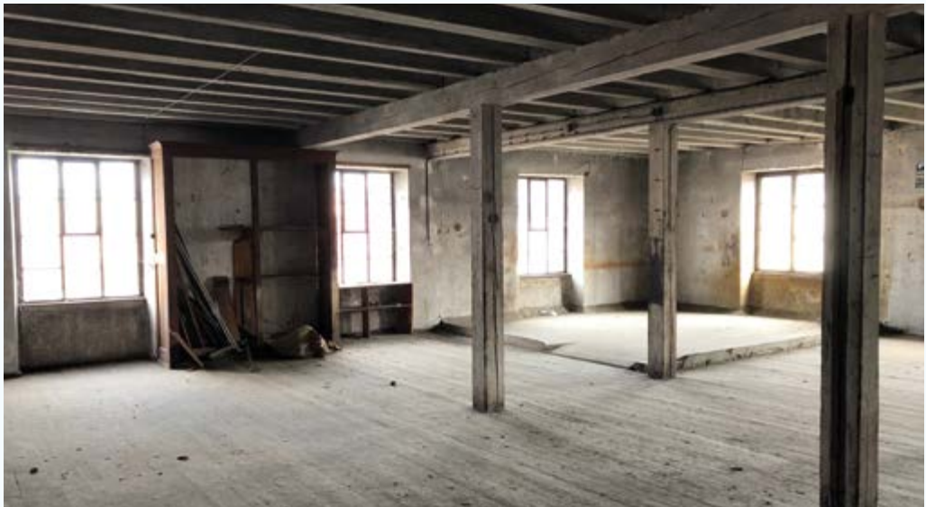
Intérieur du bâtiment Miroir Cité futur Grand Atelier, Mulhouse (68)
